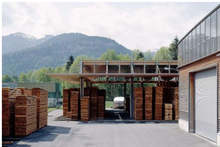
Point P –Bezau (Autriche) arch : Kaufmann & Partners Exemple d'air de stockage visible avec une intégration dans le volume
